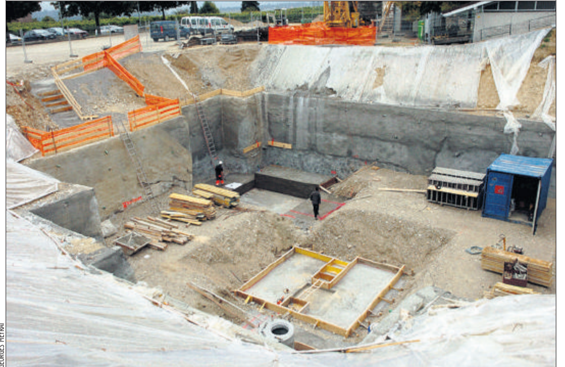
LE CHANTIER La décision d'enterrer complètement le chauffage à distance et à bois augmente le coût de cet ouvrage imposant. Mais ce choix permettra de rendre la place de Fleuri dans son intégralité à la fin des travaux. BEGNINS, LE 24 SEPTEMBRE 2008
